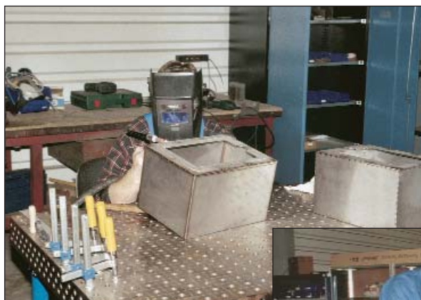
Bau einer Lüftungstechnischen Einrichtung und Justierung einer Pilotanlage zur Luftentkeimung.
